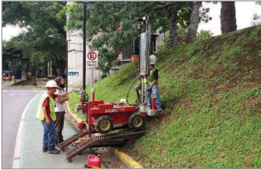
Figura 2. Ensayo de penetración dinámica en un talud de alta pendiente
